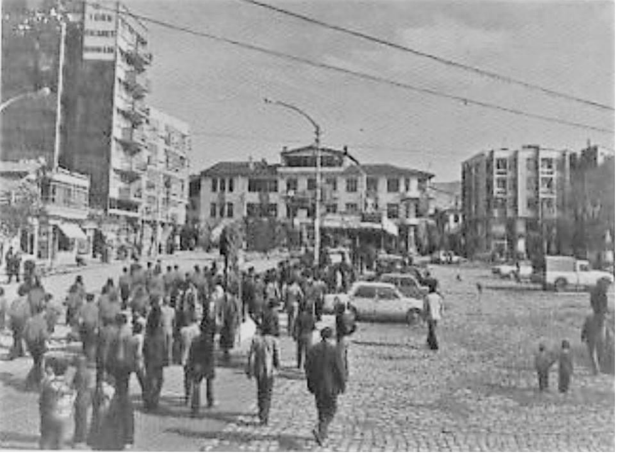
1970'ler. PTT Meydanı ve yıkılan Belediye Binası (Bu resimdeki mekânlar şimdi oldukça farklı)
